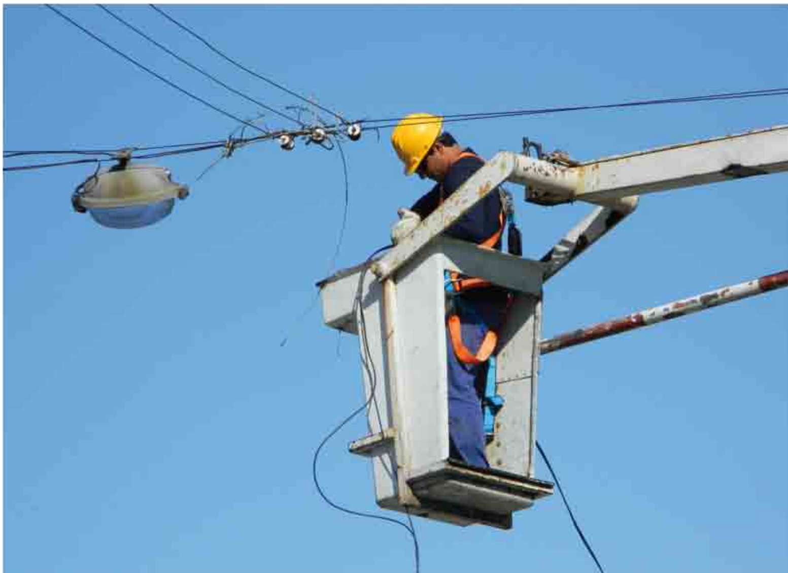
Trabajos de alumbrado en Av. Lezica
