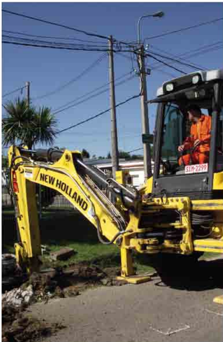
Trabajo de cuneteo_Equipo de Gestión Vial
